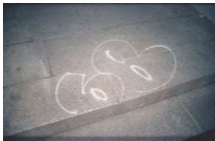
Floor + Stairs (Item: 68)
