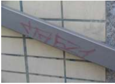
Railing/handrail (Item: MA 621)
