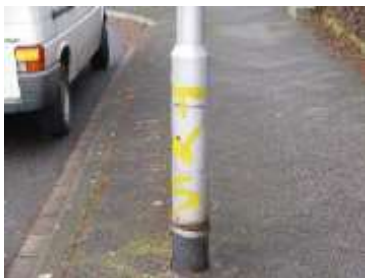
Mast (Item: TNS)
